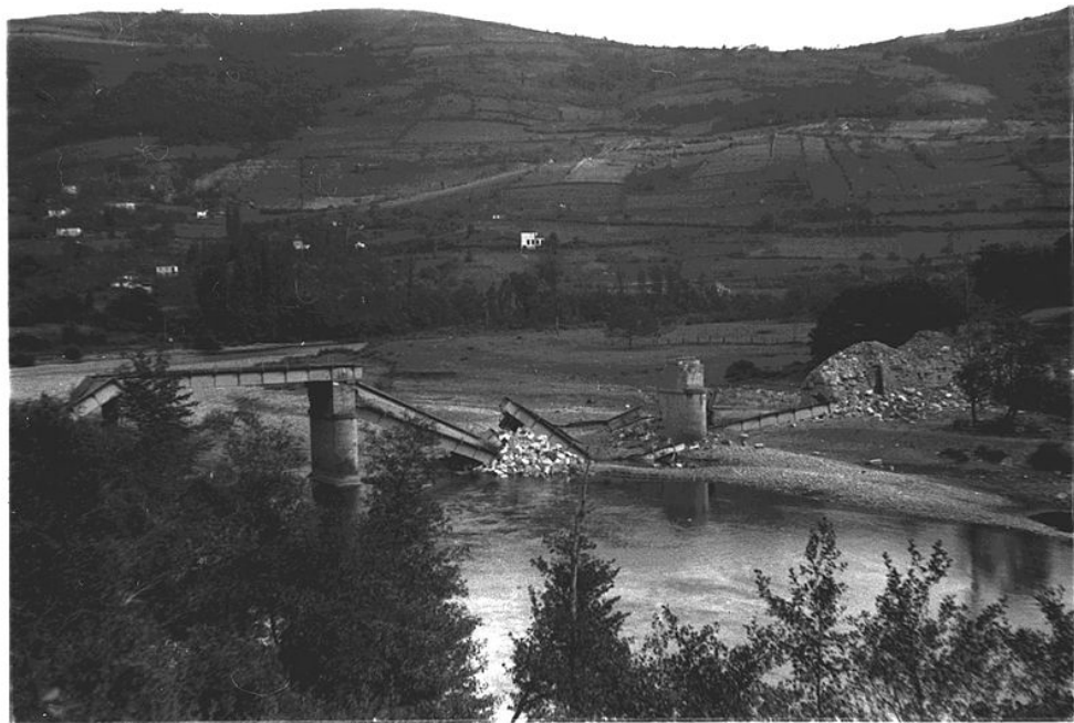
Puente sobre el río Nalón destruido en el sector militar de Grado (Asturias)
